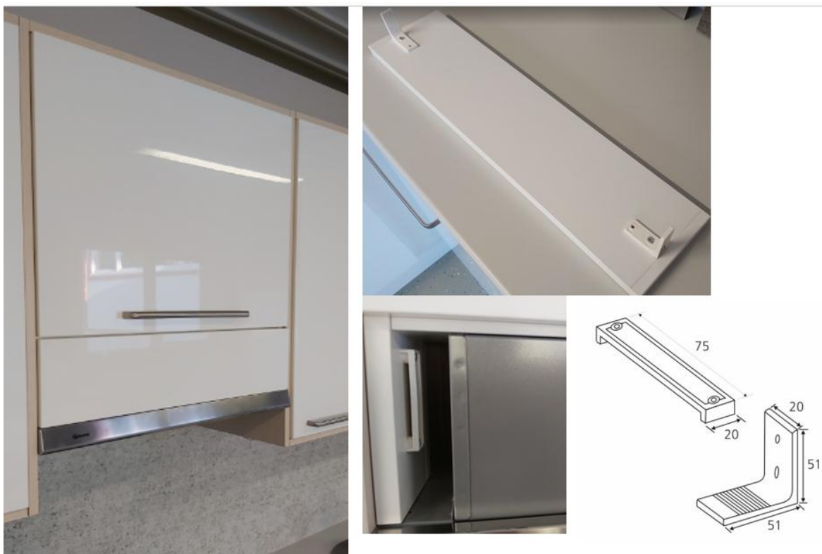
Tuuletin kaapin peitelevyn asennus havainne.
