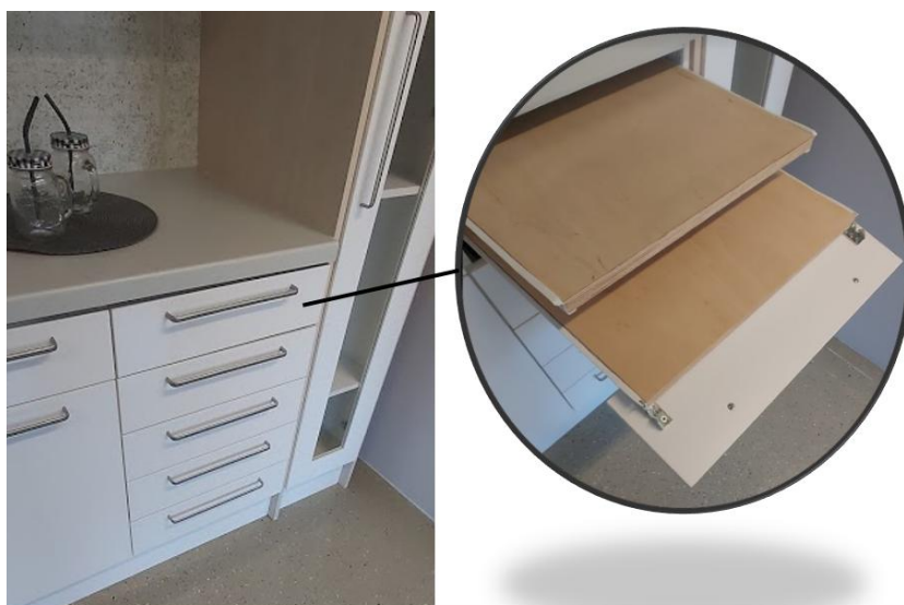
Tuuletin kaapin peitelevyn asennus havainne.
